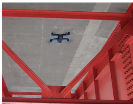
ドローンによる点検
